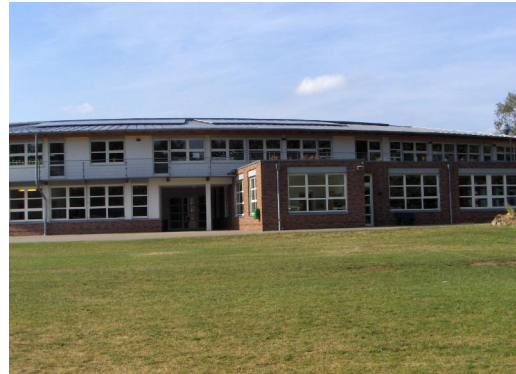
Albert-Schweitzer-Schule mit einer PV-Anlage
